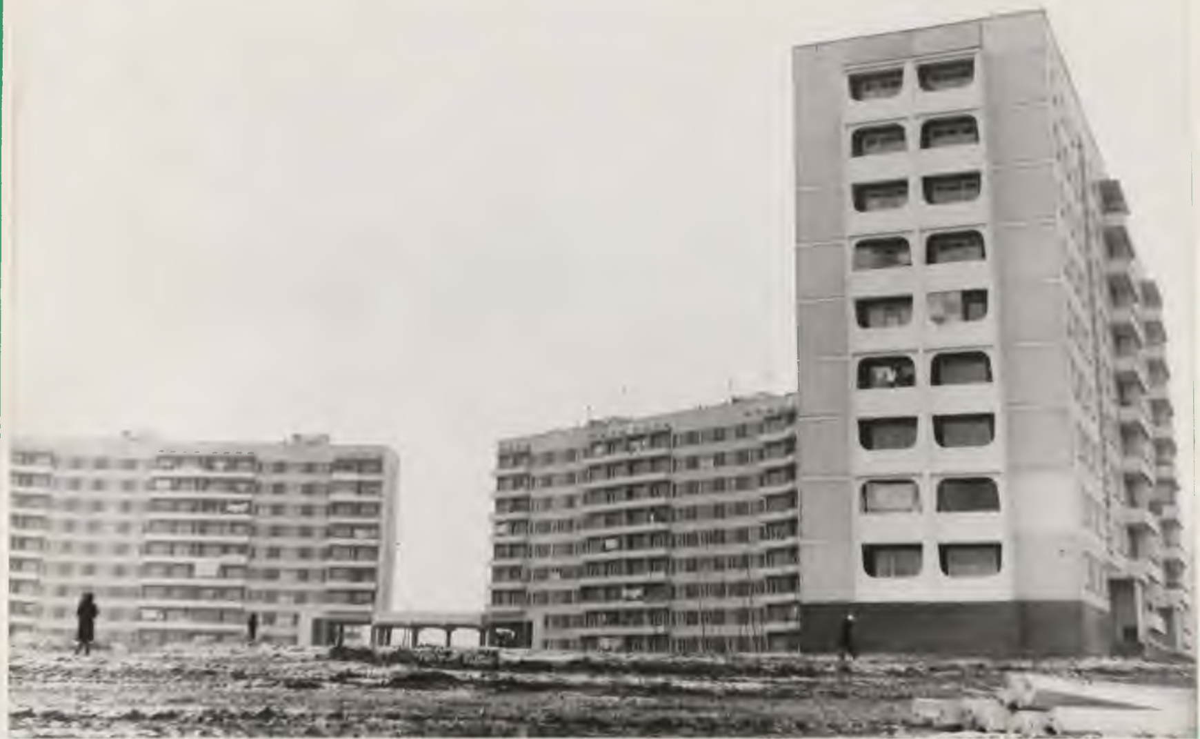
Дом № 14-15 мкрЗ Днепрострой-11. Общий вид со стороны гл. фасада. Проем выполнен с применением двухмодульных солнцезащитных панелей, разработанных в ДСР.
