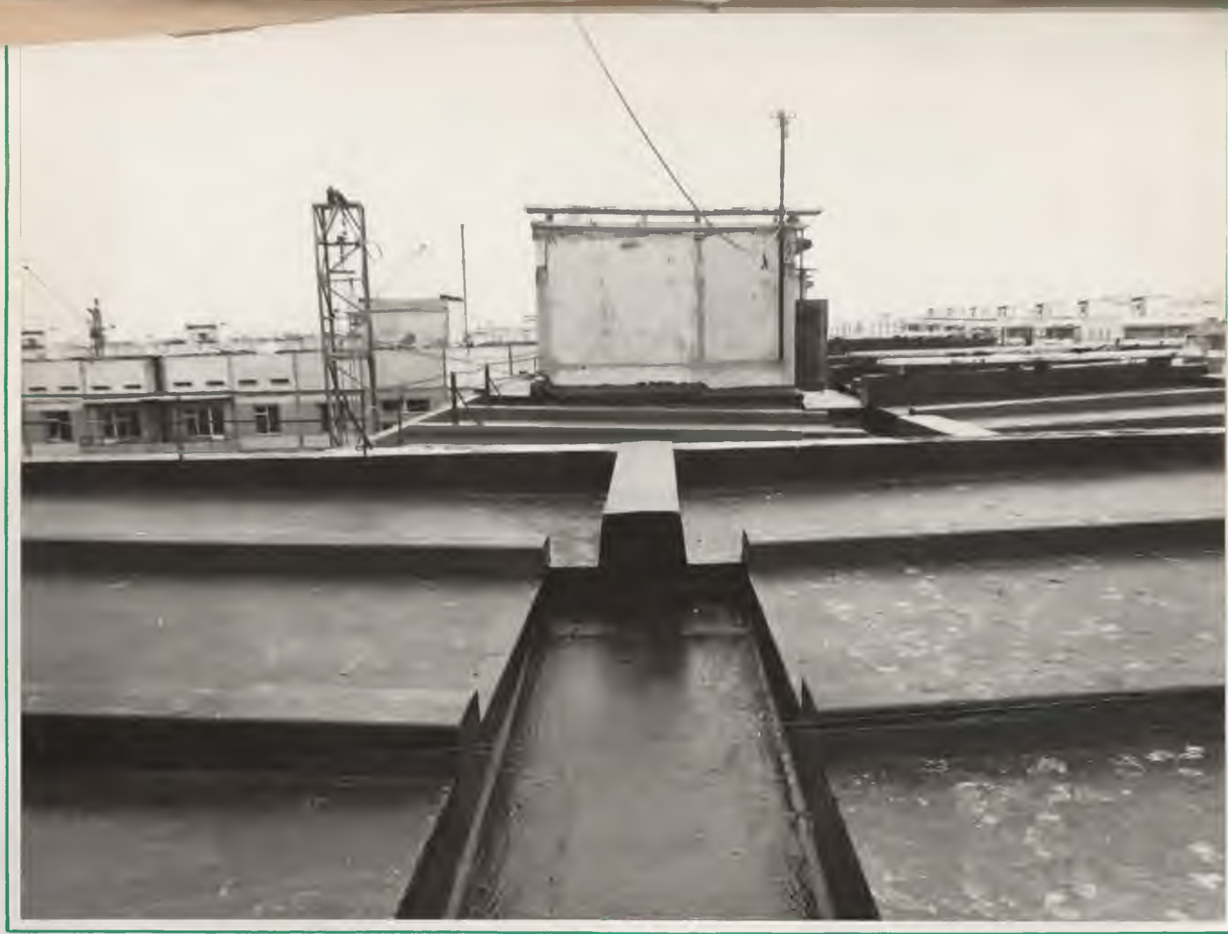
Дом № 14-15 м/р 3 Днепрострой-II. Безрулонная кровля, общий вид.
