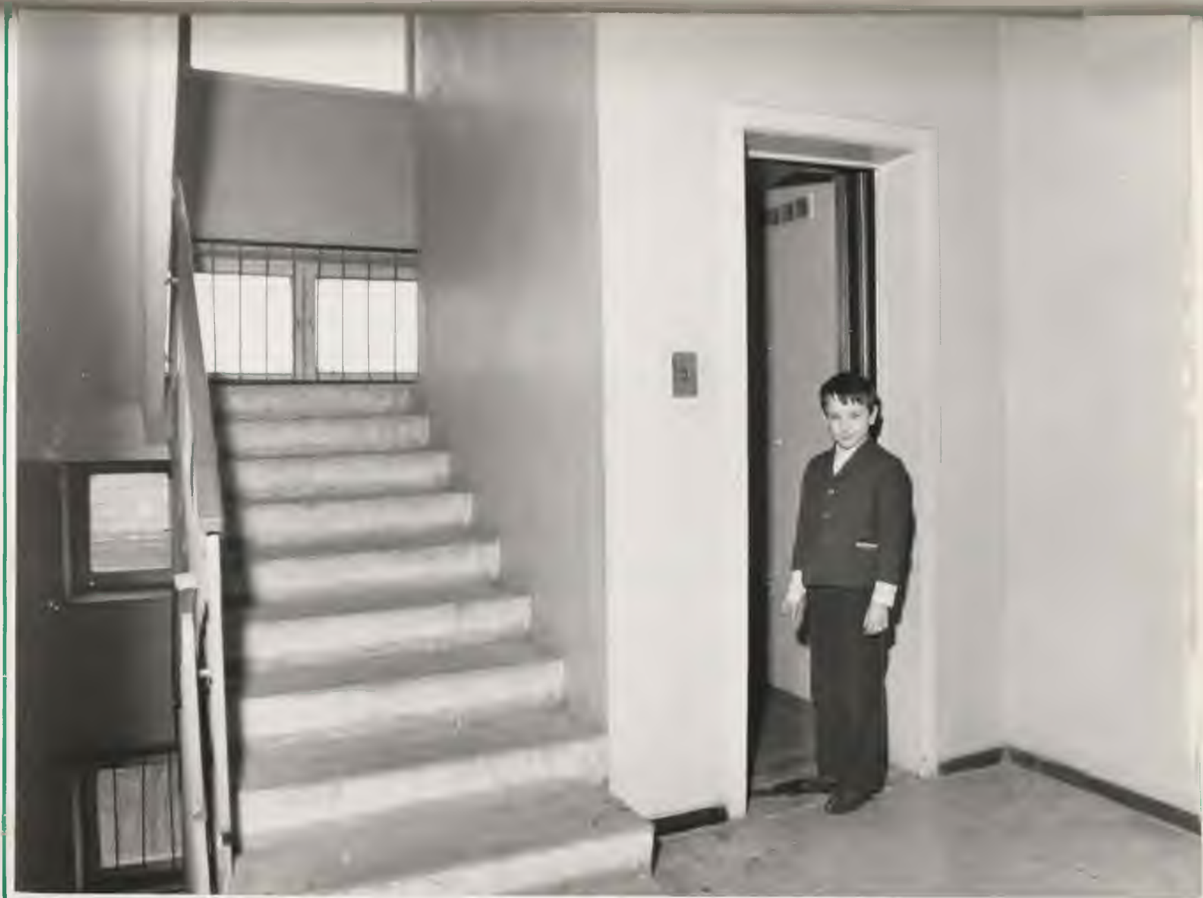
Дом № 14-15 м/р 3 Днепропетрой - II. Отделка лестничной клетки.
