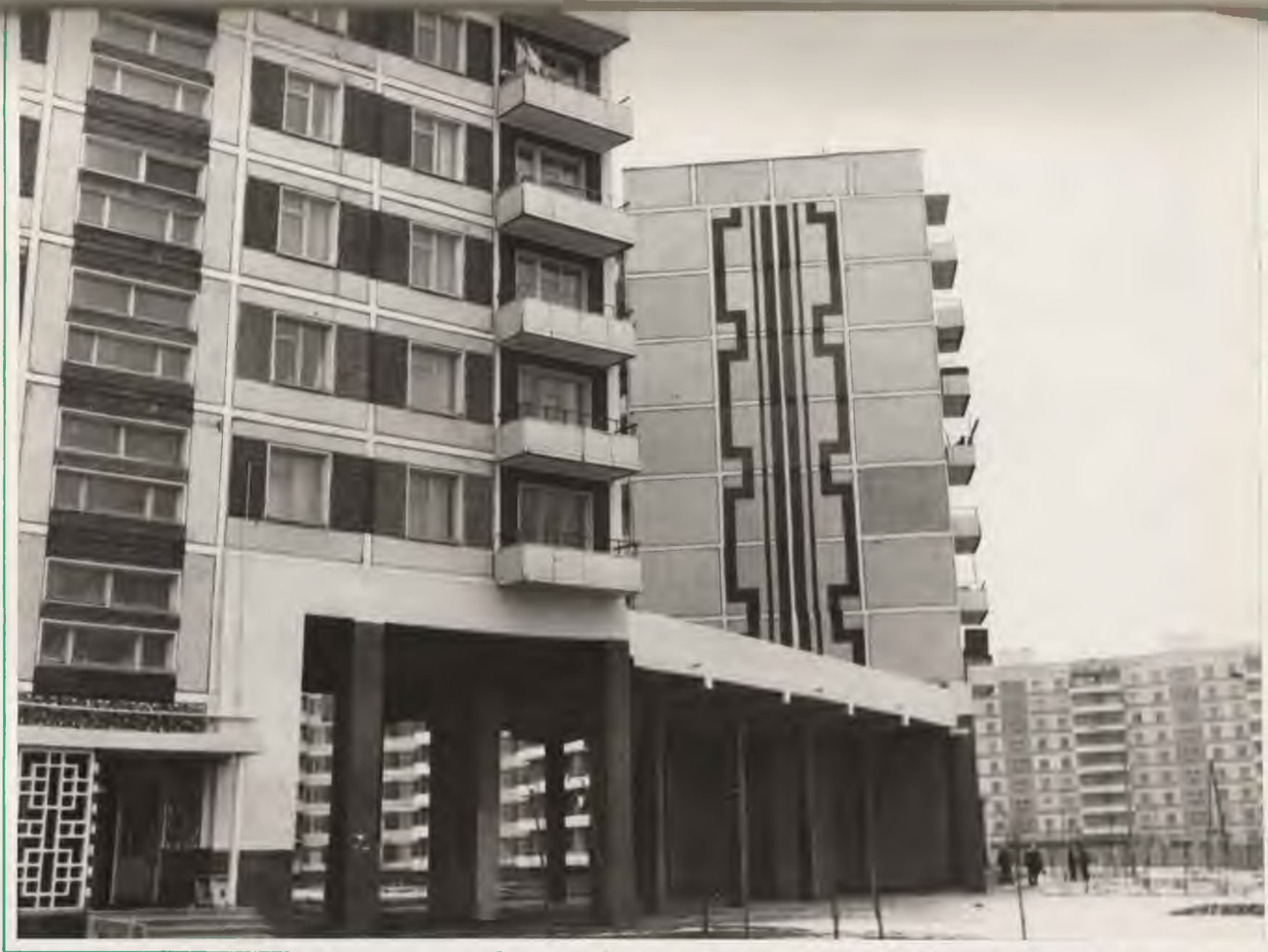
Дом № 14-15 шпр 3 Дмитровской-II. Проезд. Оформление глухих торцов орнаментом из цветной глазурованной керамической плитки типа „кабанчик“.
